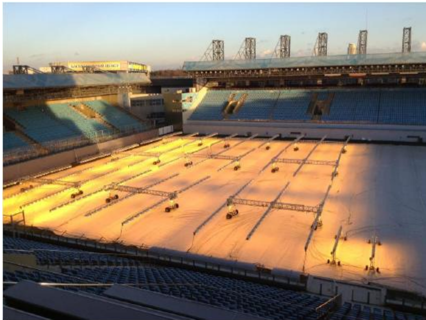
Мал. 13 Комплексне застосування освітлювальних установок та навісу на полі
