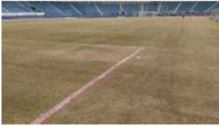
На полі немає система підґрунтового обігріву. Не змогли забезпечити належне трав'яне покриття газону до матчу УЄФА.
