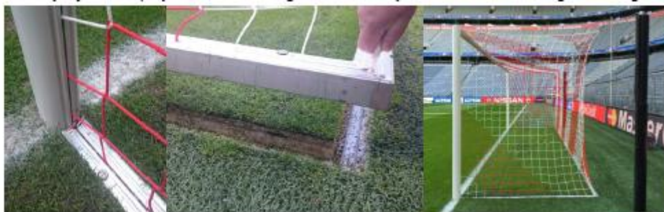
Мал. 24 Рамки ворiт вбито у заглибини на поверхнi поля
