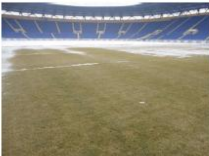
Система підґрунтового обігріву поля працює слабо та не справляється із рівномірним прибиранням снігу та паморозі на полі.
