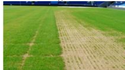
Сильне пошкодження ділянки поля через надмірне навантаження на систему захисту поля під час концерту.
