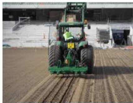
Мал.7 Установка труб підґрунтового обігріву вздовж профілю
